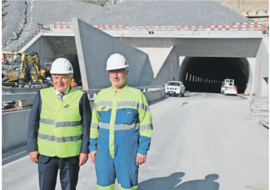
Autobahnbrücke. Staatsrat Jacques Melly (links) und der Chef des Amtes für Nationalstrassenbau, Martin Hutter, vor dem Portal der Nord- und Süd röhre der Umfahrung Visp.
